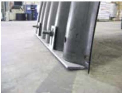
Стоманен профил, монтиран за конструкцията с отворено напречно сечение Flat steel mounting to the structure with an open cross-section
