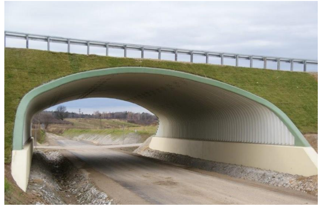
Стоманен мост / водосток SuperCor steel culvert / bridge
