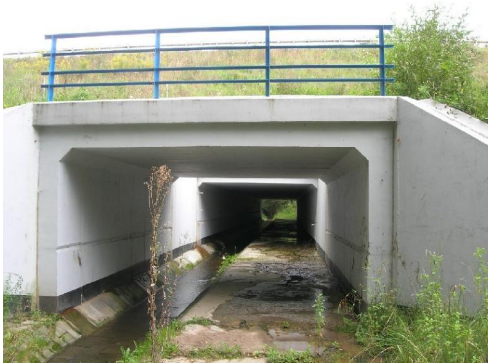
Стоманобетонен водосток / мост Concrete culvert / bridge
